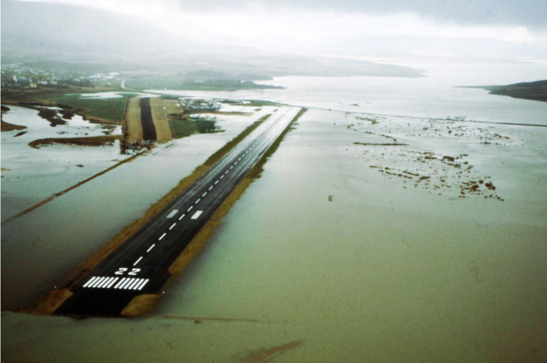
Mynd 4. Egilsstaðaflygsvöllur umflotinn vatni.
